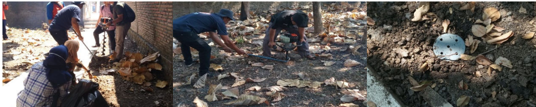
Gambar 2. Pembuatan Lubang Resapan Bioporo
