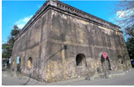
Gambar 4. Panggung Krapyak tampak sudut samping dan belakang
